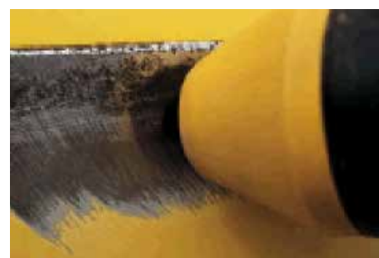
Rez, která pronikla do hloubky kovu, lze odstranit pískováním.
